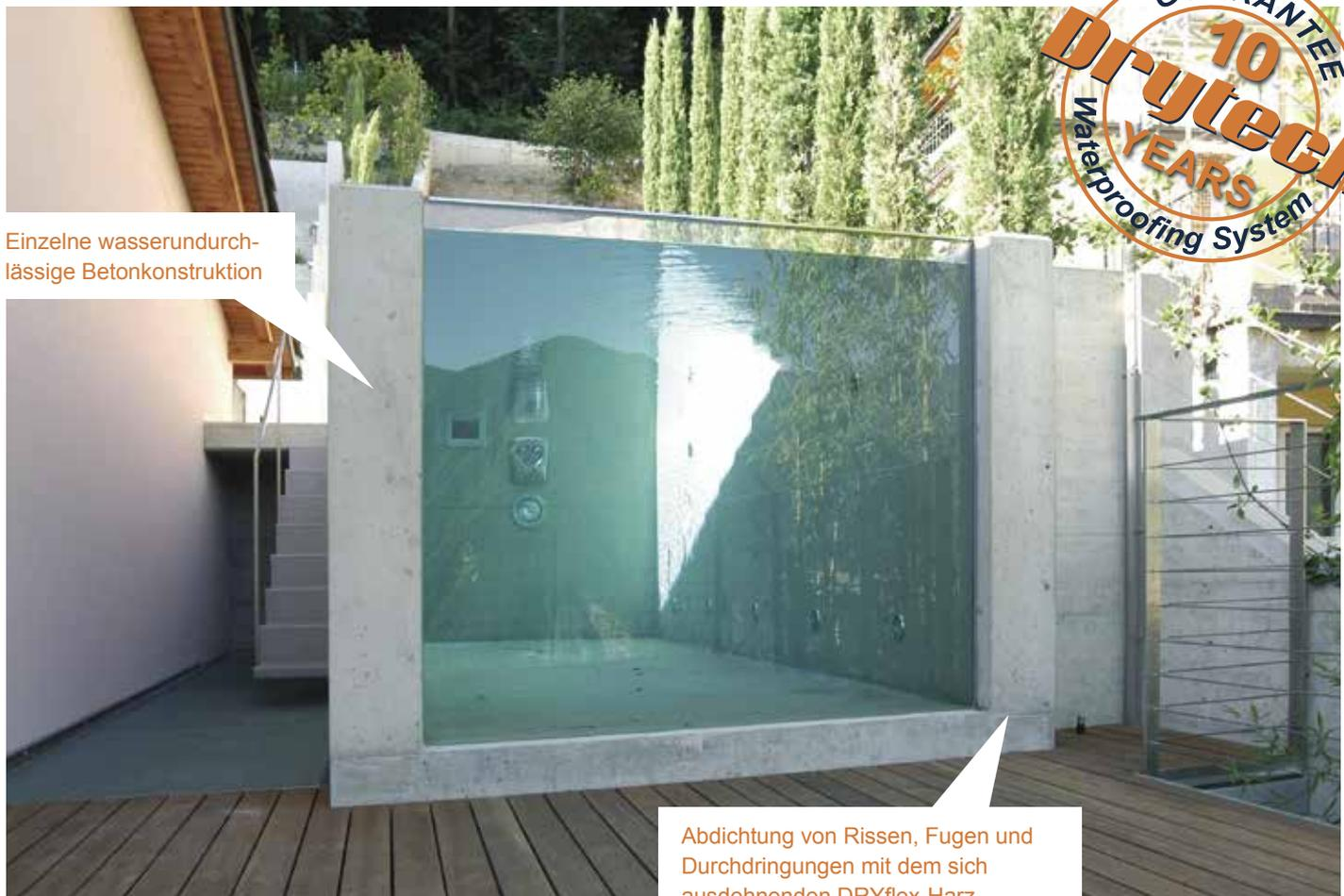
Einzelne wasserundurchlässige Betonkonstruktion
