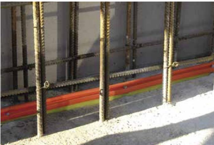
Das DRYset-Injektionsprofil wird in die Arbeitsfugen verlegt, um die kapillare Verbreitung des Harzes zu gewährleisten.
